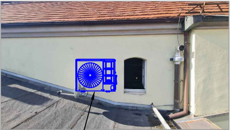
jednostka zewnętrzna montaż na ścianie budynku
